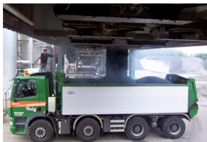
Impianto di miscelazione asfalto/calcestruzzo
