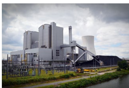
Planta de generación
